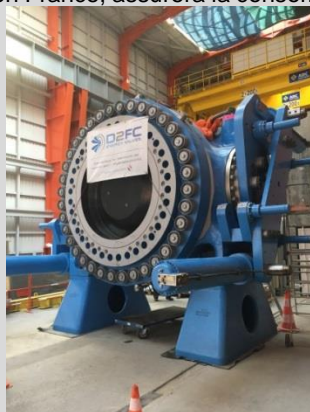
Robinet en cours d'installation sur le projet EDF à La Coche
